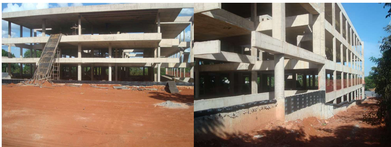
Figura 14 - Obra ESMPU Outubro 2018
